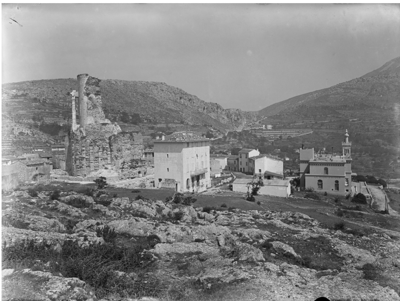
Les deux hôtels du Righi d'hiver et d'été avant leur démolition
