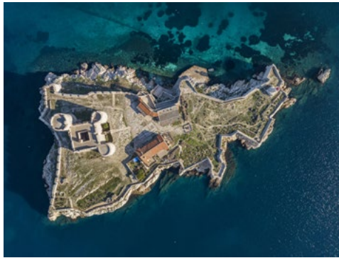
Château île d'If, vue aérienne en plongée de puis le sud-est © We are Content(s) - CMN
