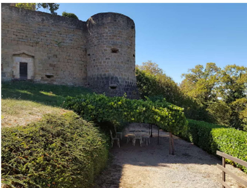
La terrasse de la maison des moines en contrebas du château
