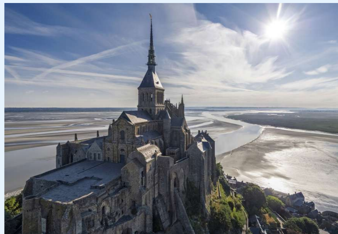
Abbaye du Mont-Saint-Michel, vue aérienne depuis le sud-ouest © Christian Gluckman - CMN
