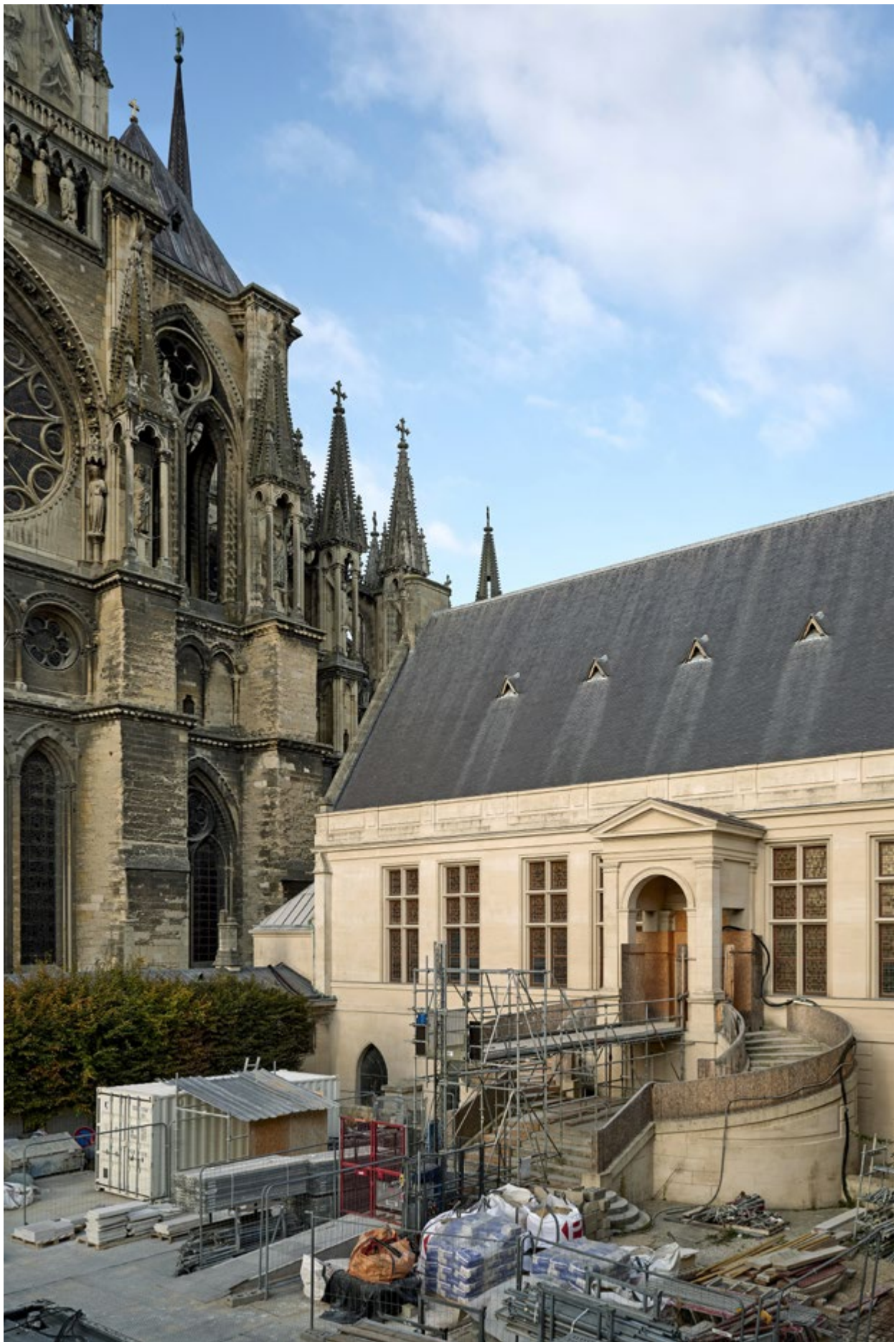
Palais du Tau, chantier © Julie Limont - CWN
