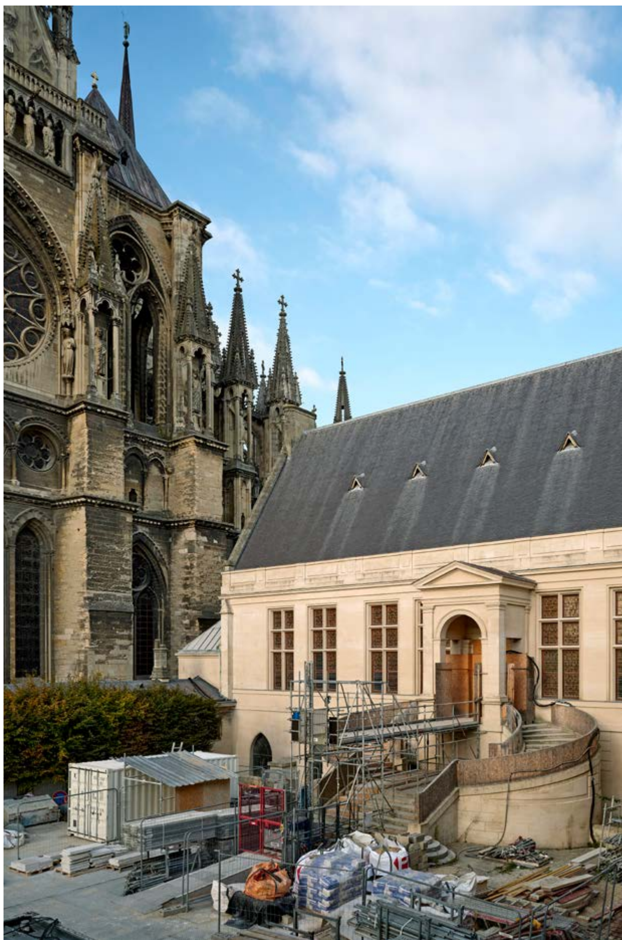
Palais du Tau, chantier © Julie Limont - CWN
