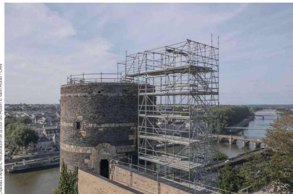
Château d'Angers, restauration de la tour du Moulin © Yann Monel - CMN
