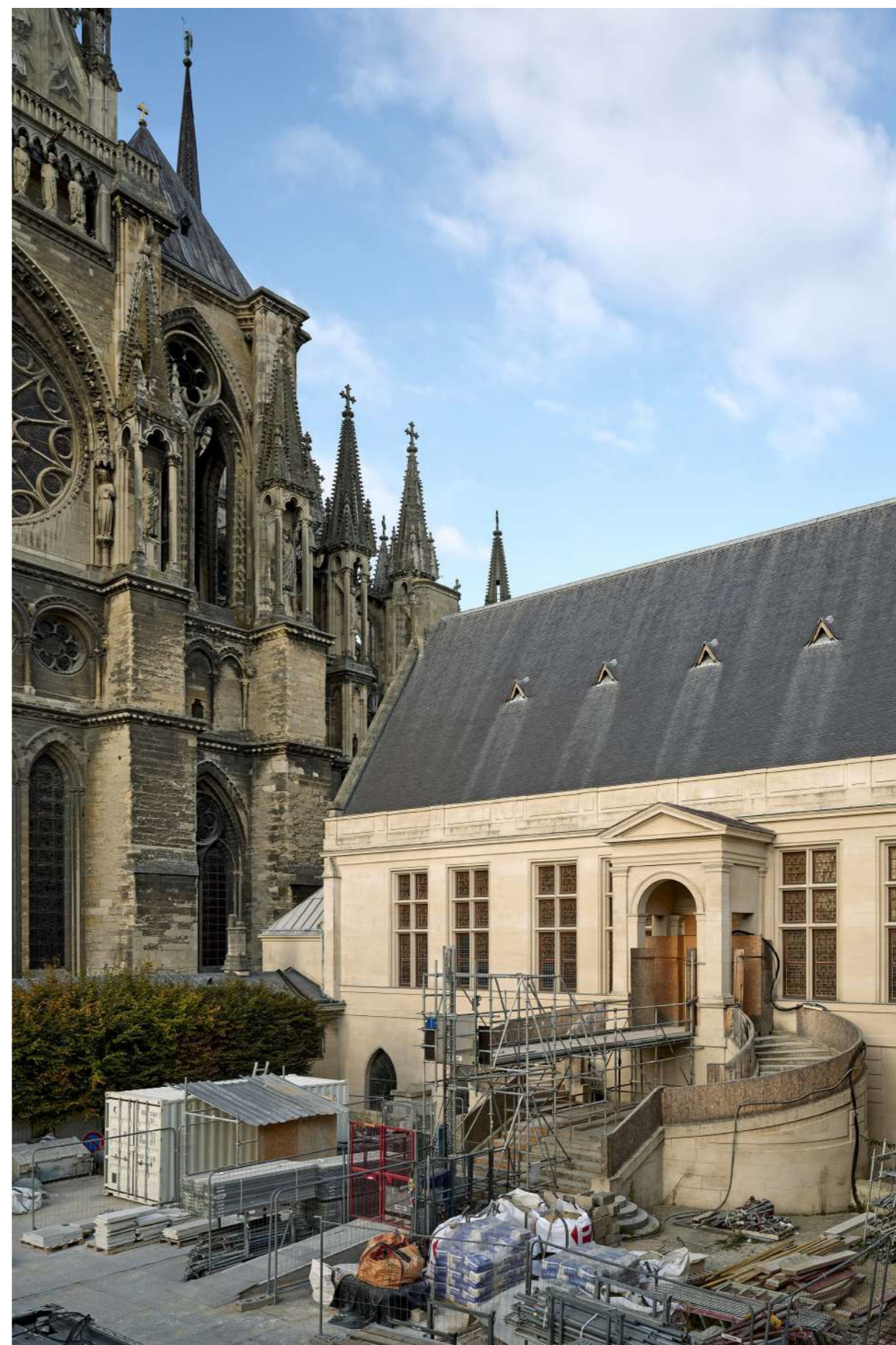
Palais du Tau, chantier © Julie Limont - CMN
