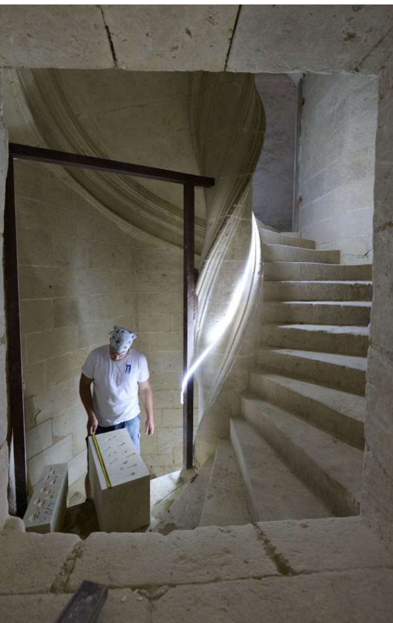
Château d'Oiron, chantier de la tour de l'Épée © Benjamin Gavaudo - CMN
