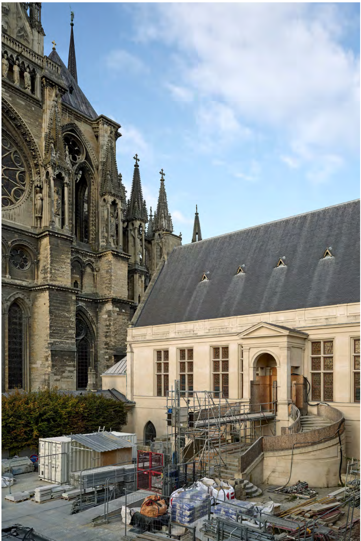
Palais du Tau, chantier © Julie Limont - CWN
