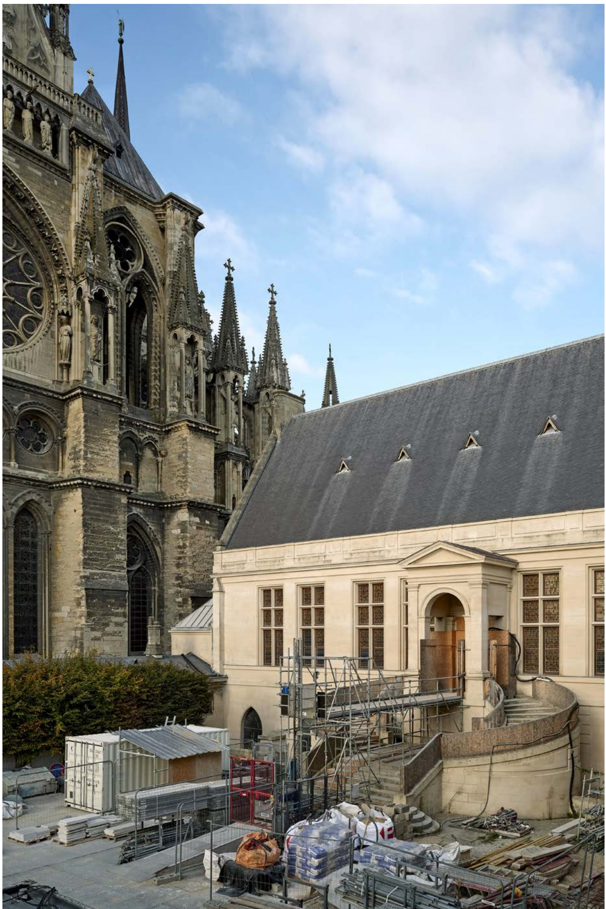
Palais du Tau, chantier © Julie Limont - CWN
