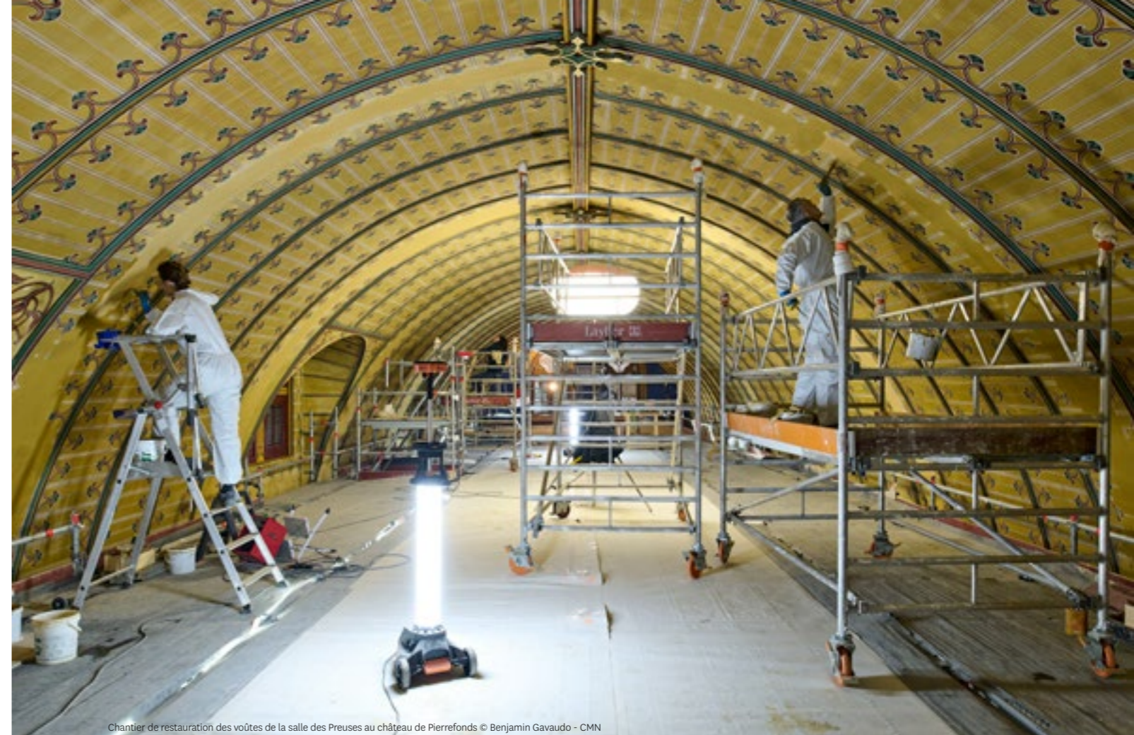
Chantier de restauration des voûtes de la salle des Preuses au château de Pierrefonds © Benjamin Gavaudo - CMN
