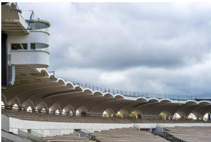
Stade Chaban-Delmas à Bordeaux Vue des tribunes, des couvertures et du porte-à-faux. Ph. Lysiane Gauthier. © Mairie de Bordeaux.
