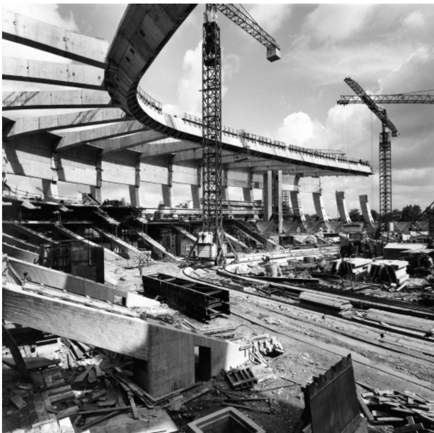
Le stade du Parc des Princes Paris XVI e Vue du chantier, en cours de construction. Photographie Ch. Baer, s. d. MMF 2016.10.1.
