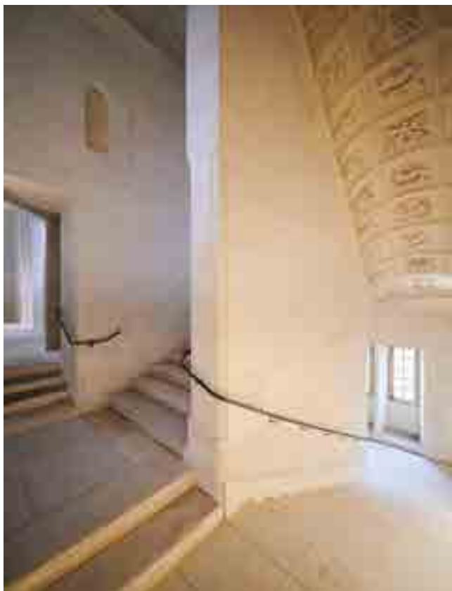
Escalier du Roi restauré © Benjamin Gavaudo - CMN
