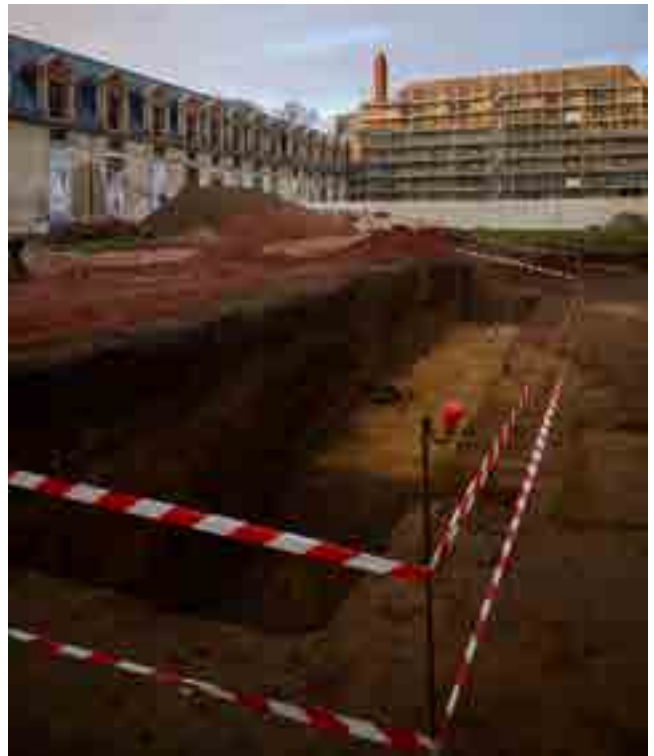
Début du chantier de fouilles, cour des Offices à l'aube © Pierre-Olivier Deschamps / Agence Vu' - CMN
