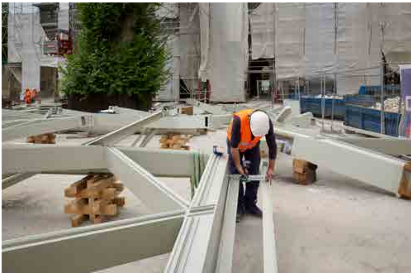
Assemblage de la structure métallique de la future verrière © Pierre-Olivier Deschamps / Agence Vu' – CMN
