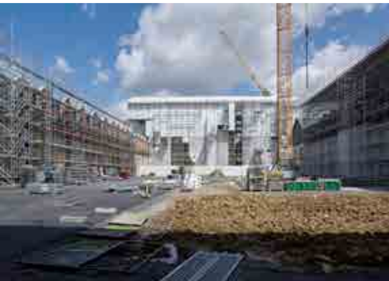
Château de Villers-Cotterêts, cours des offices en travaux © Pierre-Olivier Deschamps / Agence Vu' - CMN
