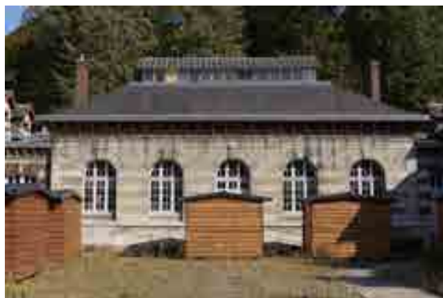
Cuisines avant restauration © Benjamin Gavaudo – CMN
