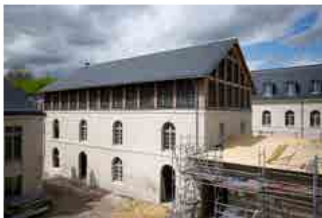
Séchoir avant restauration © Benjamin Gavaudo – CMN ; chantier de restauration du séchoir © Pierre-Olivier Deschamps / Agence Vu' – CMN
