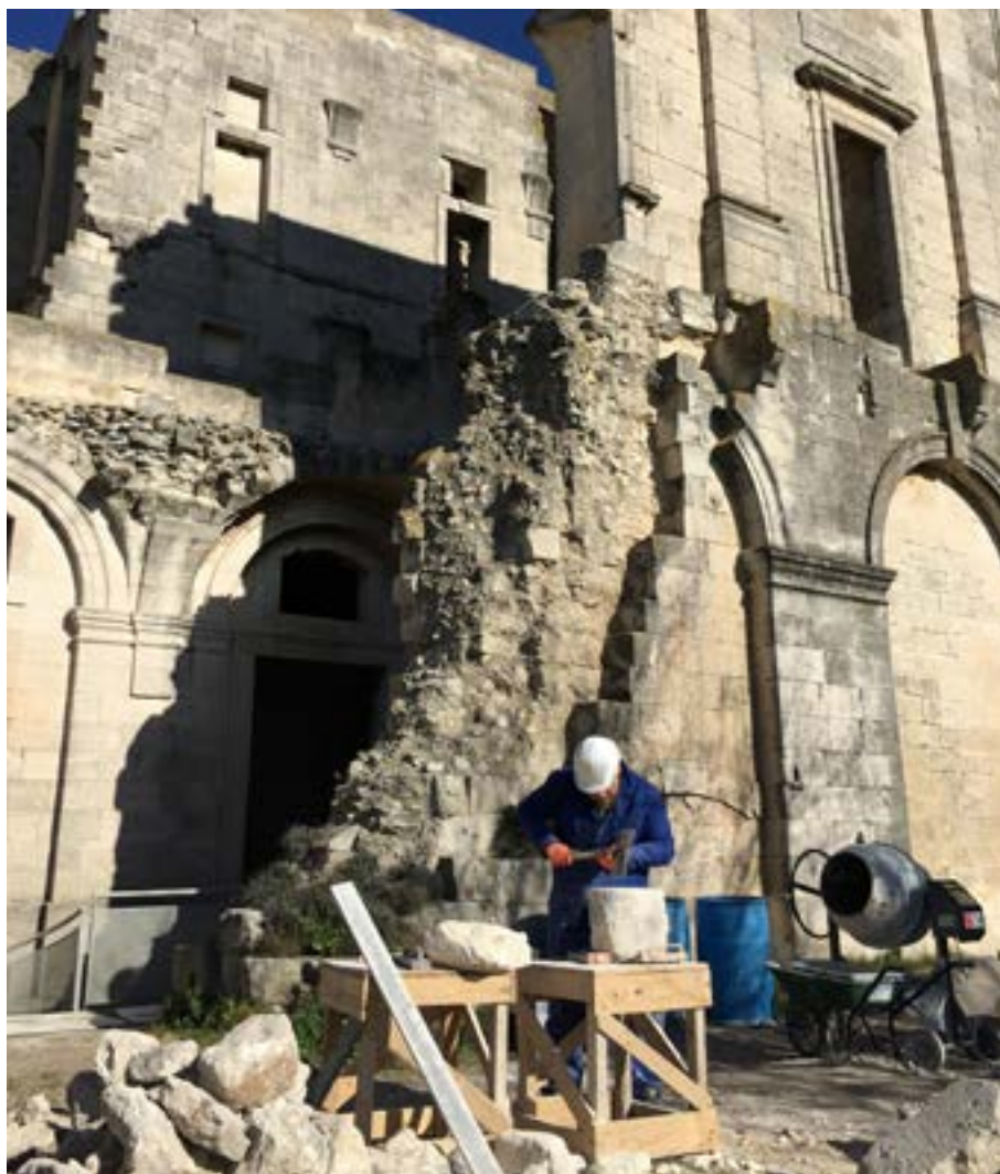
Chantier d'insertion avec ACTA VISTA à l'abbaye de Montmajour.
