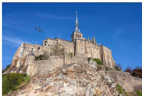
6/ Acheminement des matériaux par hélicoptère © Vincent M. – Centre des monuments nationaux
