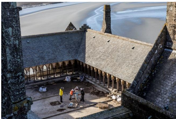
1/ Acheminement des matériaux par hélicoptère © Vincent M. – Centre des monuments nationaux
