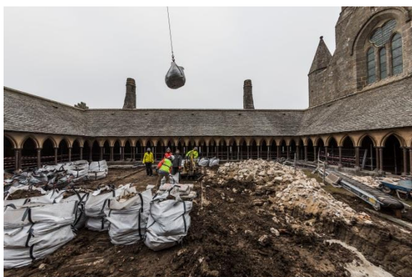
5/ Acheminement des matériaux par hélicoptère © Vincent M. – Centre des monuments nationaux
