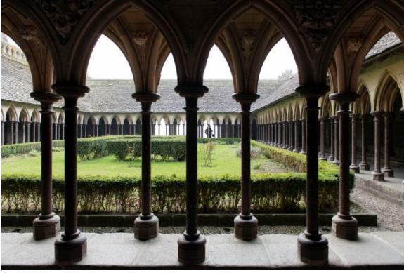
7/ Cloître de l'abbaye du Mont-Saint-Michel avant travaux © Colombe Clier – Centre des monuments nationaux
