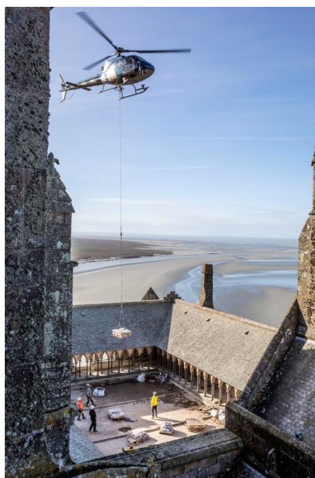
4/ Acheminement des matériaux par hélicoptère © Vincent M. – Centre des monuments nationaux
