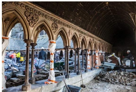
2/ Travaux du cloître du Mont-Saint-Michel © Vincent M. - Centre des monuments nationaux
